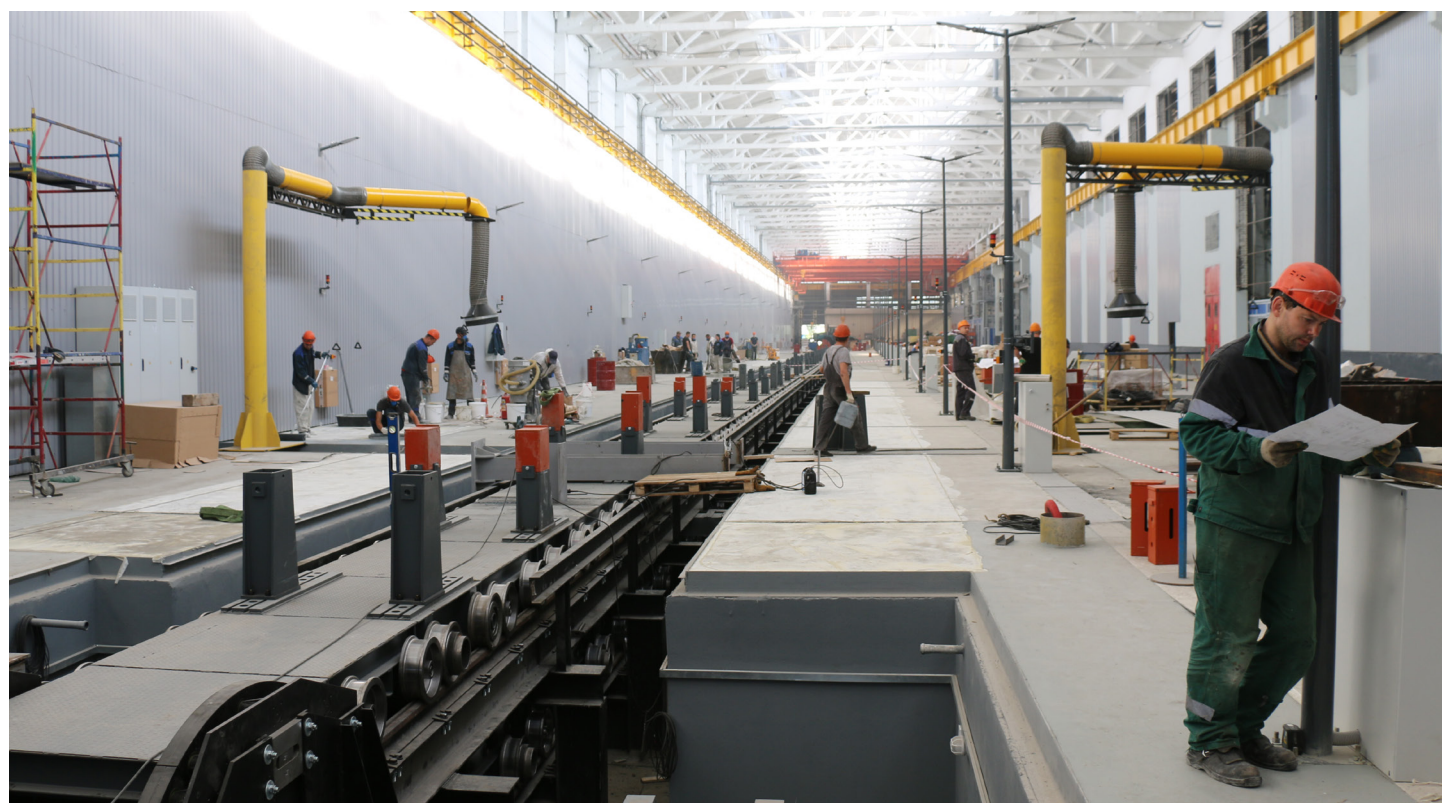
Масштабная реконструкция цеха главного конвейера
